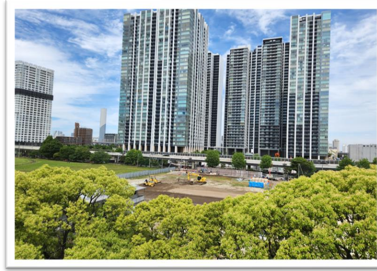
■工事の状況:重機による整地作業(撮影日:R6.5.14)
