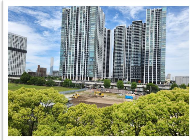
■工事の状況:重機による整地作業(撮影日:R6.5.14)
